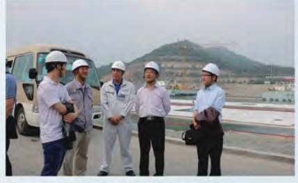
校友总会副会长黎正稳 到港珠澳大桥隧道沉管预制厂与校友交谈
