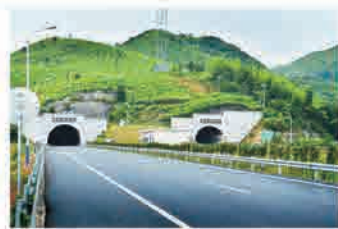
郴宁高速黄沙坪隧道
